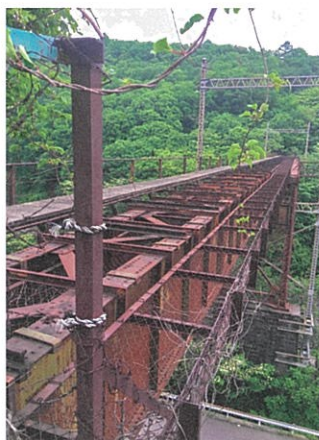
旧立場川橋梁
